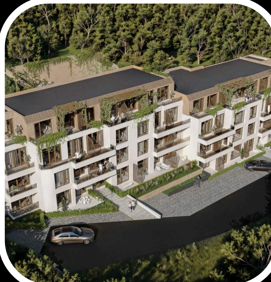
Подземный и внешний паркинг
